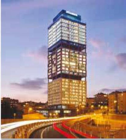
MAKYOL İNŞAAT LE MERIDIEN OTEL - İSTANBUL
