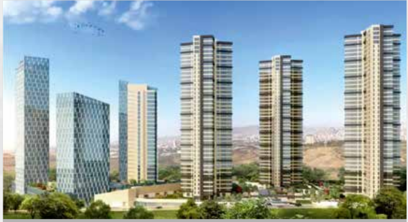
YDA İNŞAAT SÖĞÜT ÖZÜ PROJE
